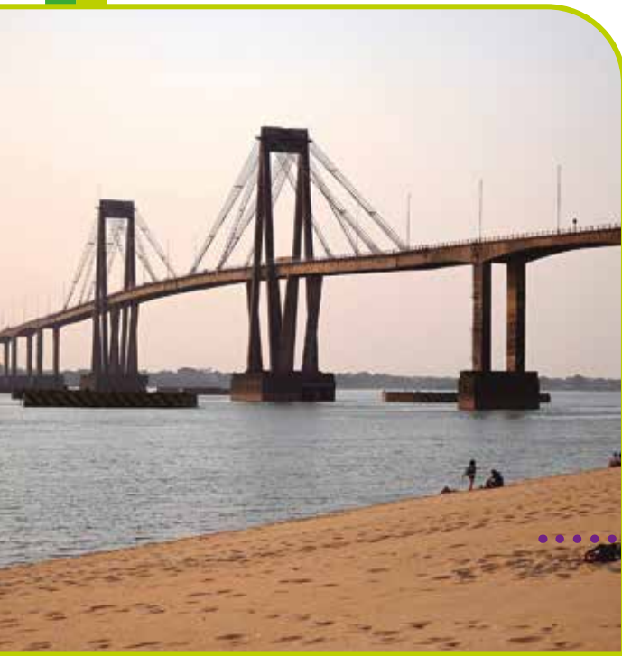
» El puente General Manuel Belgrano une las ciudades de Corrientes y Resistencia (capital de la provincia del Chaco). Esta obra fue muy importante para facilitar la circulación sobre el río Paraná, tanto de personas como de mercaderías.
