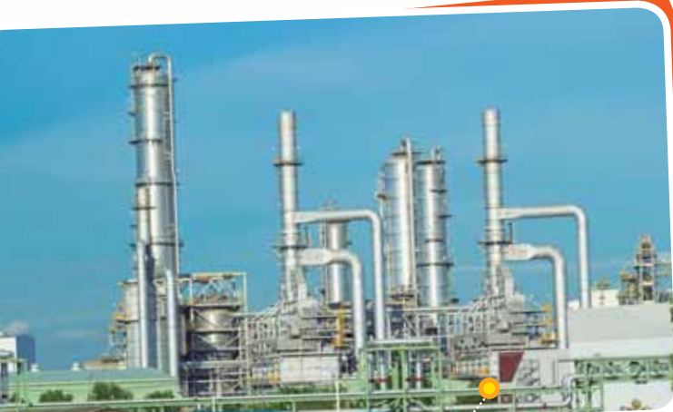
Columnas de fraccionamiento en una refinería de petróleo.
