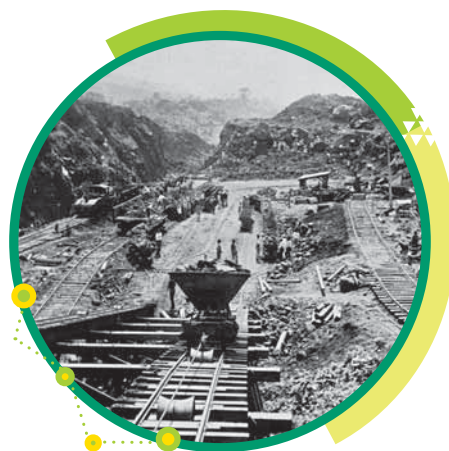
Obras para la construcción del Canal de Panamá, en 1907. Este canal permitió la comunicación entre el mar Caribe y el océano Pacífico.
