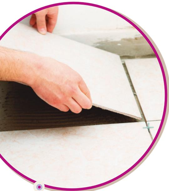
Cuando se colocan las baldosas en un piso hay que dejar suficiente espacio entre ellas para evitar que se resquebrajen cuando hace calor debido a que se dilatan.
