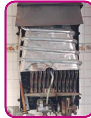
Los calefones tienen un sistema de conductores metálicos que van calentando el agua que está en contacto con ellos.
