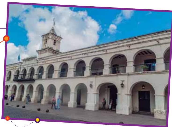
Vista actual del Cabildo de la ciudad de Salta.
