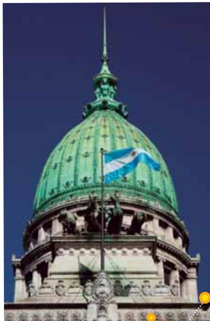
La cúpula del Congreso de la Nación tiene un revestimiento de cobre. Sin embargo, debido a la corrosión del metal tiene un color verde característico.
