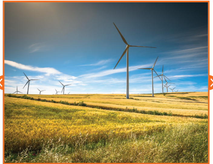
Los molinos de viento se utilizan para producir energía eléctrica.
